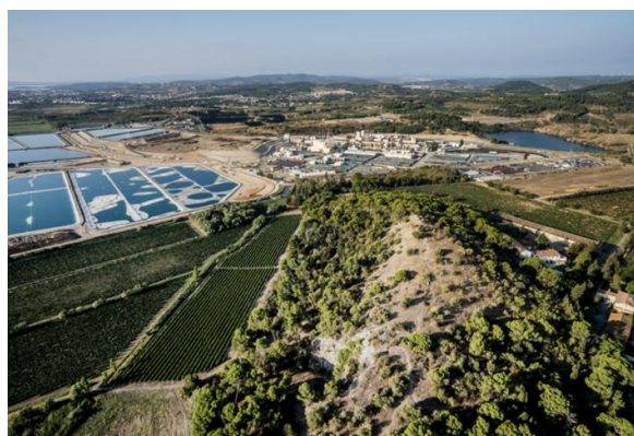
Figure 1 : Site d'ORANO-CE Malvési à Narbonne
